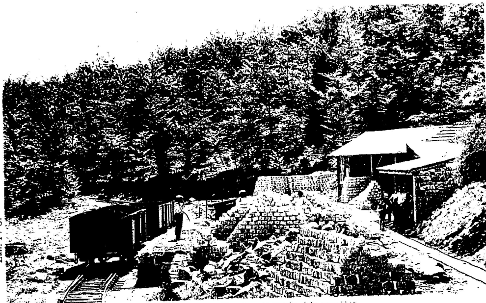
7. CORCELLES — Chantier de pavés, à la carrière
