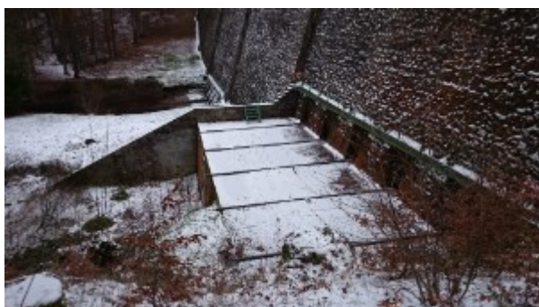
Sorties des drains du masque de Lévy et mesure de leurs débits (de 0 à 90 litres/minute)
