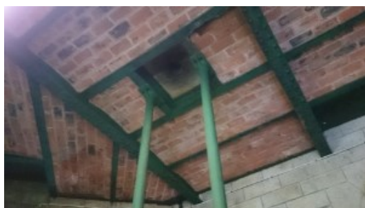
Le départ des 2 évents dans la salle du rez-de-chaussée
