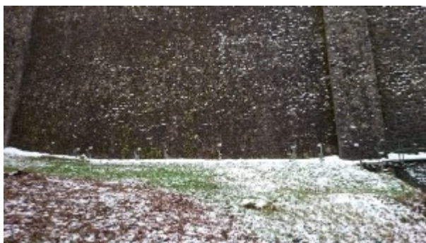
Sortie des accès piézométriques et des drains en pied de digue et accès piézométriques sur la digue
