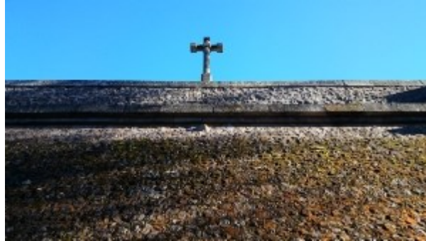
La croix vue du mur aval et cette curieuse « excroissance »
