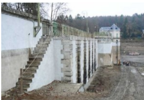
Travaux 2008 Photo DDT 58
