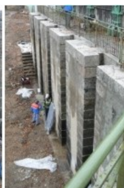
Réparations complémentaires en 2008 et état du mortier d'imperméabilisation en 2021 (Photos DDT58)
