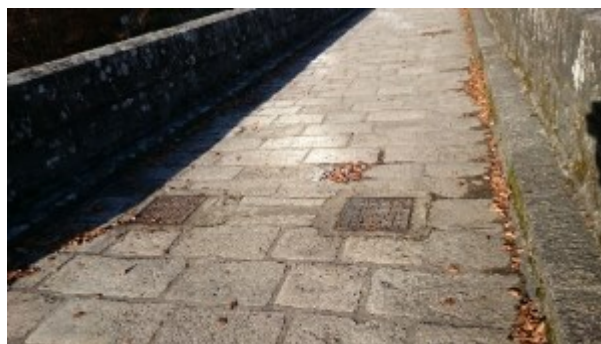
Sortie des accès piézométriques et des drains en pied de digue et accès piézométriques sur la digue
