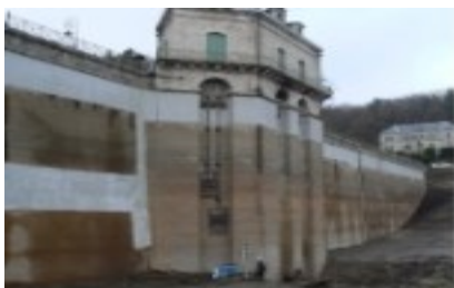
Réparations complémentaires en 2008 et état du mortier d'imperméabilisation en 2021 (Photos DDT58)
