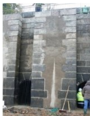
Réparations complémentaires en 2008 et état du mortier d'imperméabilisation en 2021 (Photos DDT58)
