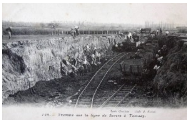
Illustration des travaux entre Nevers et Tamnay
