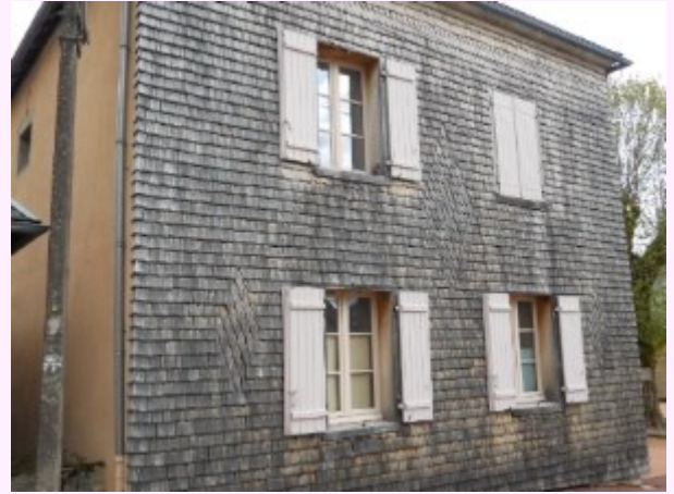
Façade de maison à Anost
