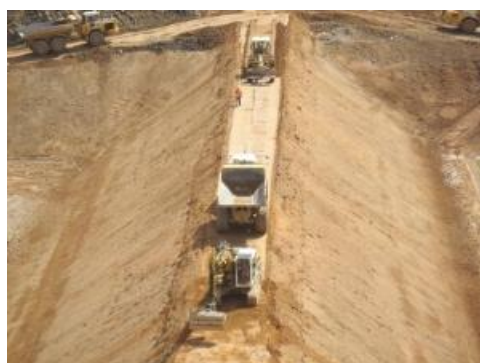
Pose du batardeau (Photo Seine Grands Lacs, reproduction interdite)
