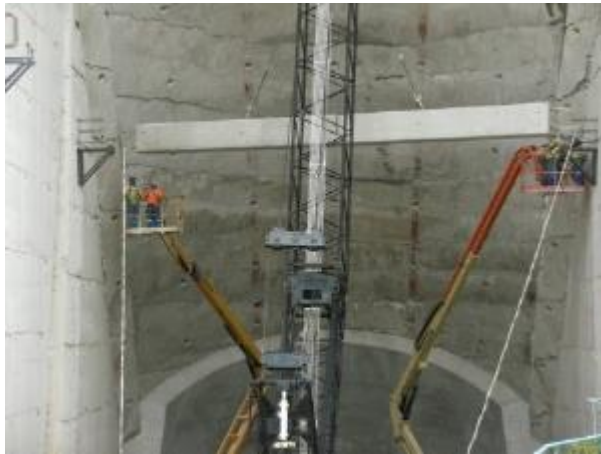
La pose des butons (Photos Seine Grands Lacs, reproduction interdite)
