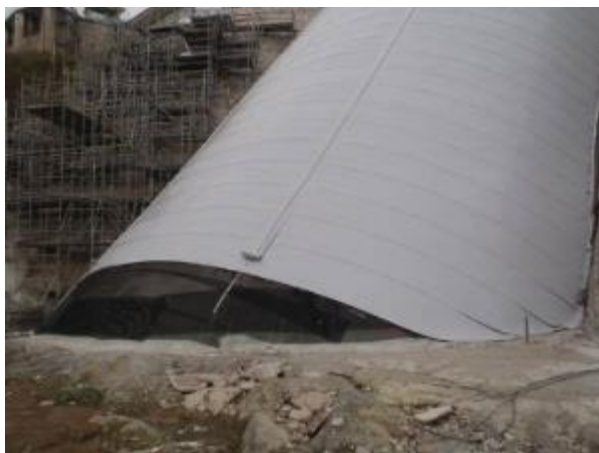
Pose de la géomembrane (Photo Seine Grands Lacs, reproduction interdite)
