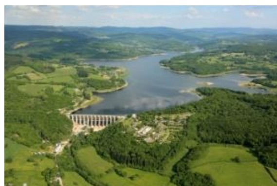
Vue générale après travaux (Photo Seine Grands Lacs, reproduction interdite)
