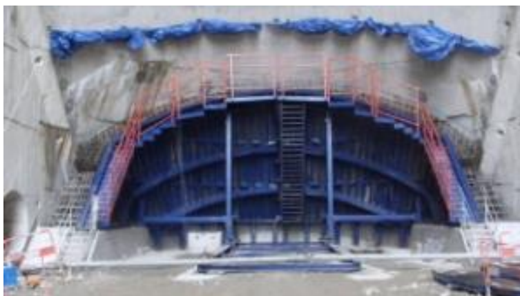
Un pied de voûte (Photo Seine Grands Lacs, reproduction interdite)
