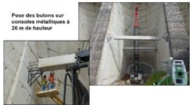
La pose des butons (Photos Seine Grands Lacs, reproduction interdite)
