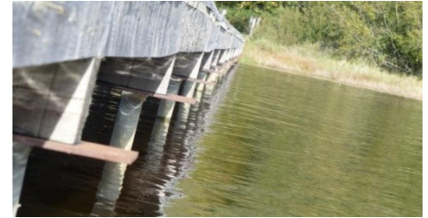
Exemple passerelle et Techno pieux à St Agnan (Cliquez pour agrandir les images)
